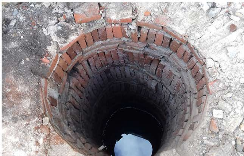
Poço identificado no decorrer da obra [foto CC]
