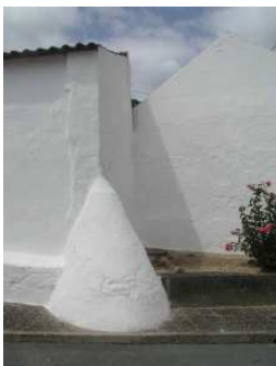
Casa térrea com cunhal – foto do CAA
